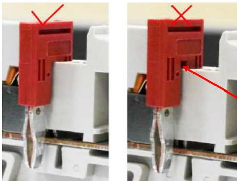
横联与基座之间有缝隙，则表示没有插到位
