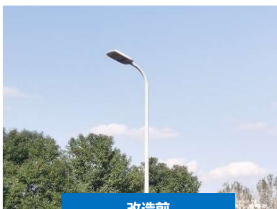
改造前 电能 路灯
