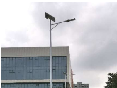
改造后 太阳能 路灯
